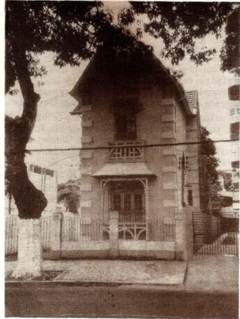
FIGURA 17 - Chalet na Av. Gov. José Malcher 884, entre Quintino Bocaiuva e Joaquim Nabuco.
