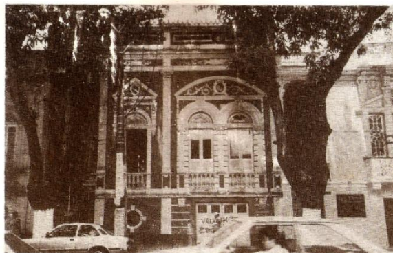
FIGURA 7 - Exemplo Acesso Lateral. Fachada Eclética mas Implantação no Lote e Divisão Interna nos Moldes Coloniais. Av. Gen. Deodoro entre Nazaré e Gov. José Malcher
