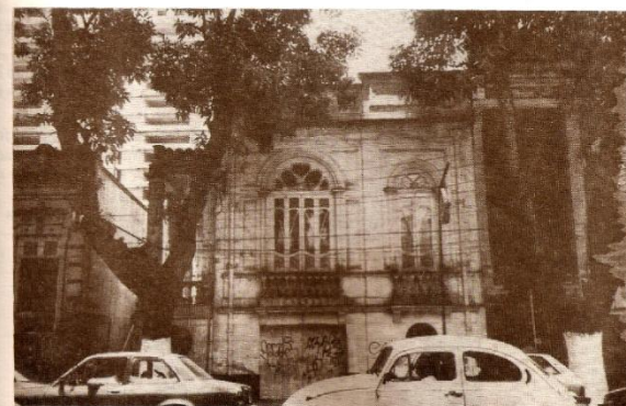
FIGURA 10 - Exemplo de Fachada com Decoração Eclética. Av. Gen. Deodoro entre Nazaré e Gov. José Malcher.
