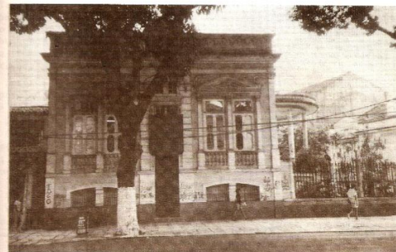
FIGURA 9 - Implantação com Afastamento Lateral, Pátio de Acesso em Semi-Círculo. Alinhamento Frontal e Disposição de Portas e Janelas do Tipo Colonial. Fachada Eclética. Av. Nazaré Esquina da Quintino Bocaiúva.
