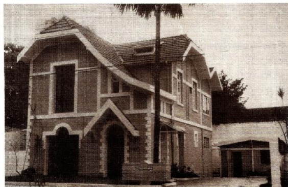
FIGURA 22 - Chalet na Rua Conselheiro Furtado nº 631 entre Padre Eutíquio e São Pedro.
