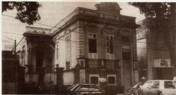
FIGURA 13 - Residência com Fachada com Elementos Neo-Clássicos. Platibanda Desconforme. Av. Nazaré entre Benjamin Constant e Dr. Moraes.
