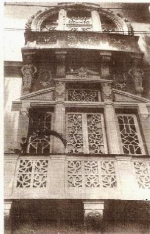
FIGURA 12 - Detalhe da Fachada da Residência sito à Av. Gen. Deodoro entre Nazaré e Av. Gov. José Malcher.
