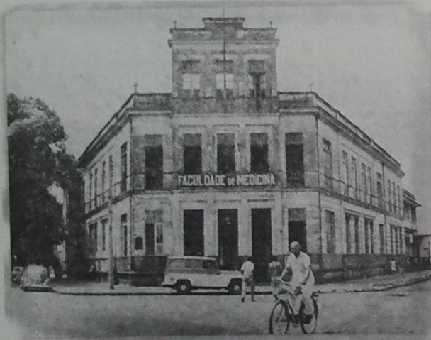
Servindo hoje como sede do Centro Bio-Médico, neste prédio, situado à Praça Camilo Salgado, funcionava a Faculdade de Medicina quando da criação da Universidade.
